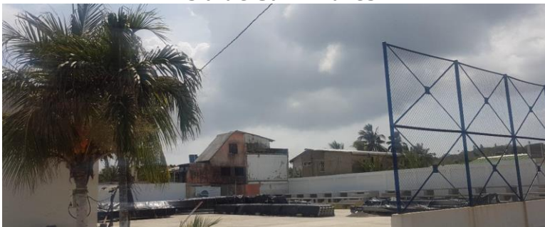
Fotografía 22 Obras de Infraestructura Deportiva Isla de San Andrés
